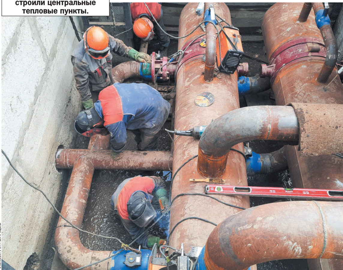
Работа подрядчиков ежедневно контролировалась.
