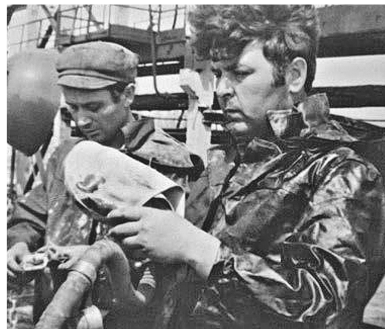
Иосиф Душанек на строительстве ПК «Шесхарис».
