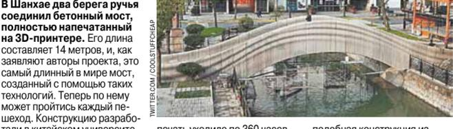
В Шанхае два берега ручья соединил бетонный мост, полностью напечатанный на 3D-принтере.
