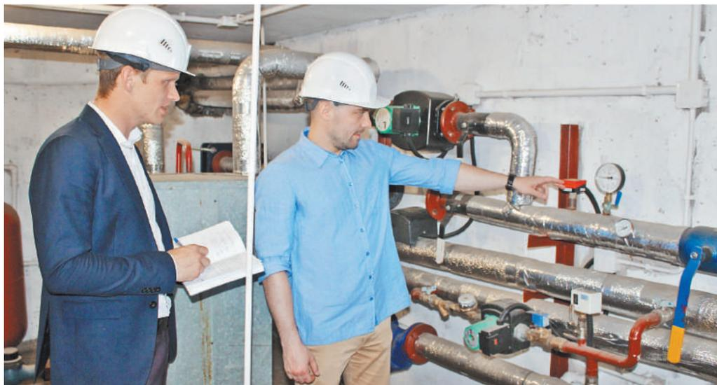
Узлы управления и регулирования потребления тепловой энергии установлены в «пилотном» доме в Калининграде.
