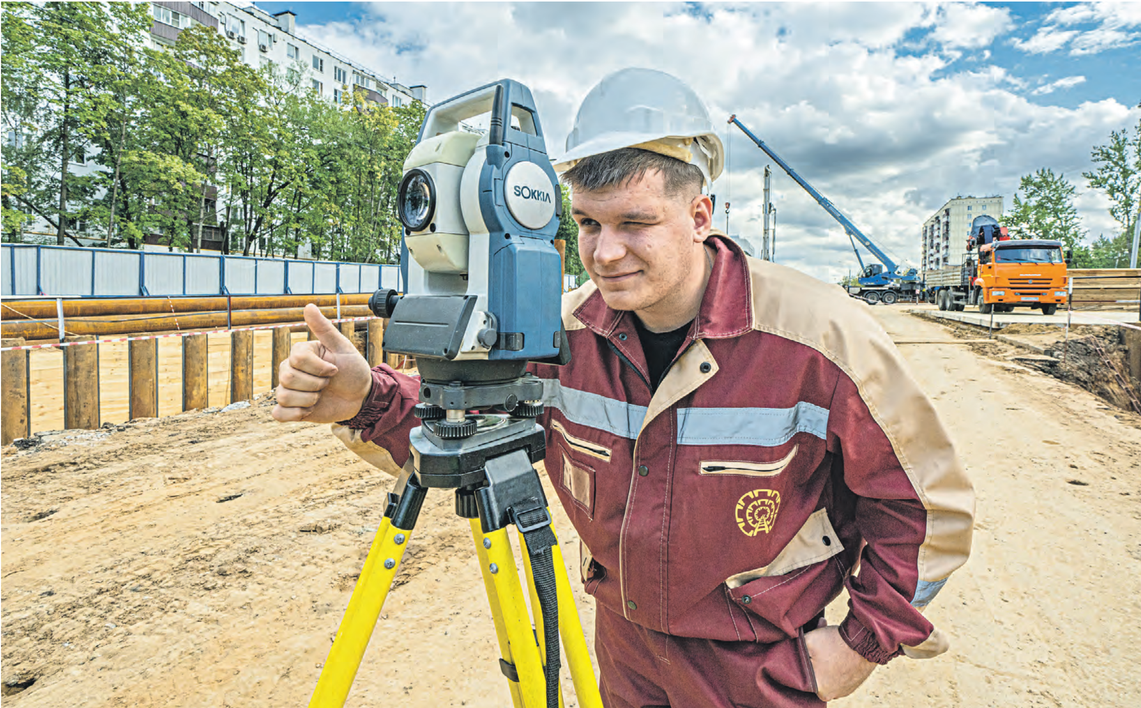
20 августа. Маркшейдер ООО «Строймехсервис Метростроя» Павел Хейлик в районе будущей станции метро «Гольяново» занимается геодезическими измерениями и разметкой
