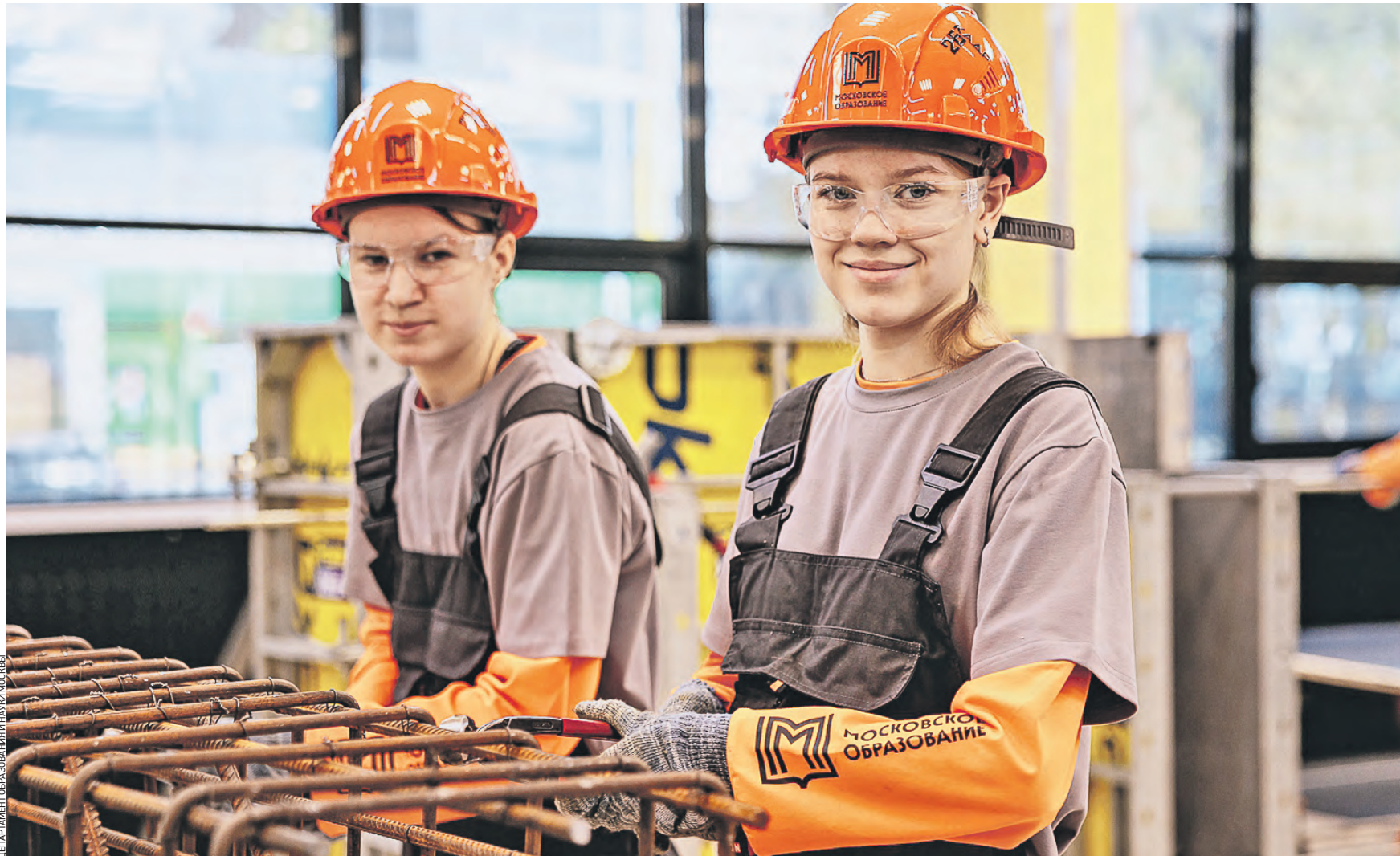
15 сентября. Студенты 2-го курса колледжа «26 КАДР» по специальности «строительство и эксплуатация инженерных сооружений» Ангелина Анянueva (слева) и Полина Стрельченок-Стрельцова на новом полигоне практической подготовки вяжут арматурный каркас, который используется для создания железобетонной конструкции
