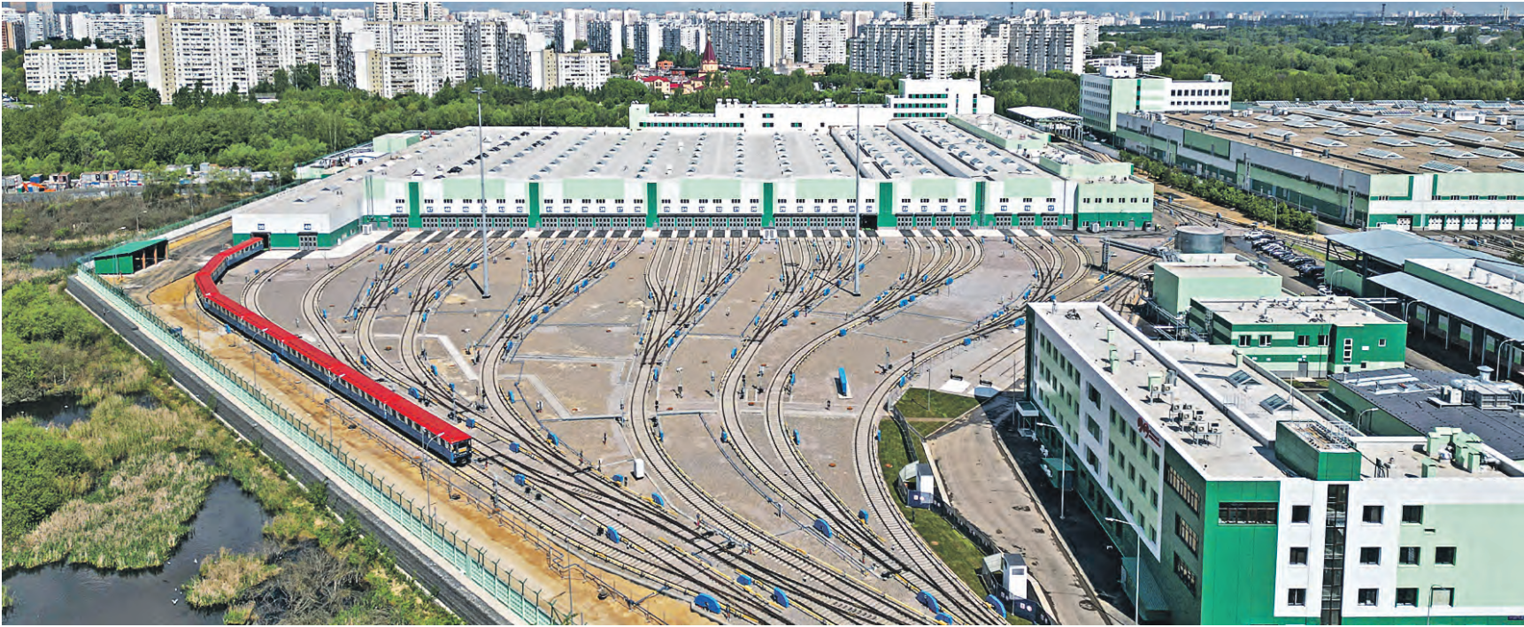
Электродепо «Южное» включает 46 зданий, обеспеченных самым современным технологическим оборудованием. Здесь обслуживают поезда Замосворецкой линии
