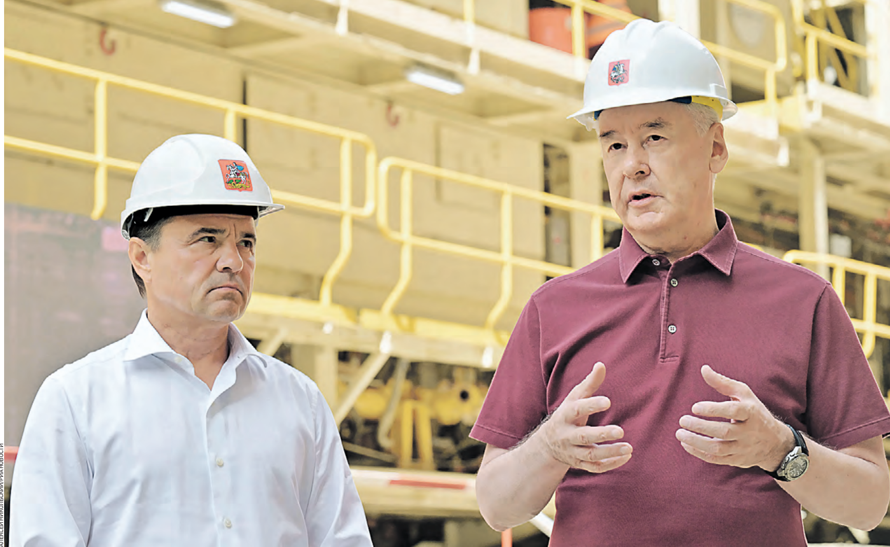
31 июля. Мэр Москвы Сергей Собянин и губернатор Московской области Андрей Воробьев (слева) проводят осмотр строительных работ по запуску проходческого щита на станции «Липовая Роща» Рублево-Архангельской линии метро
